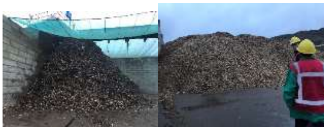
Planta de procesamiento de escombros;
